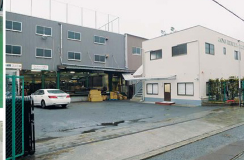
今後は新工場と同様に、既存工場の近代化も図る計画だ
